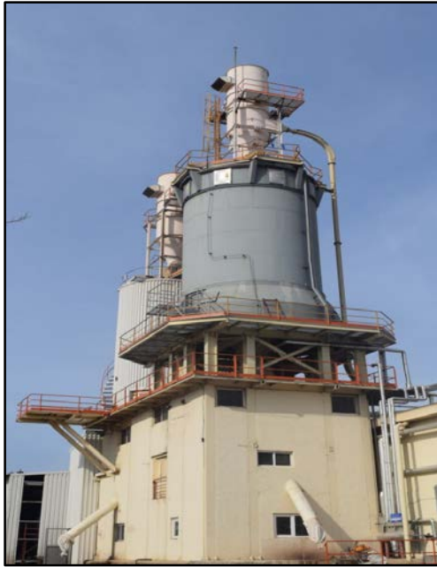
Şekil 17: Yongaların depolanması (Fotoğraf: Ufuk AYDIN 2016).
