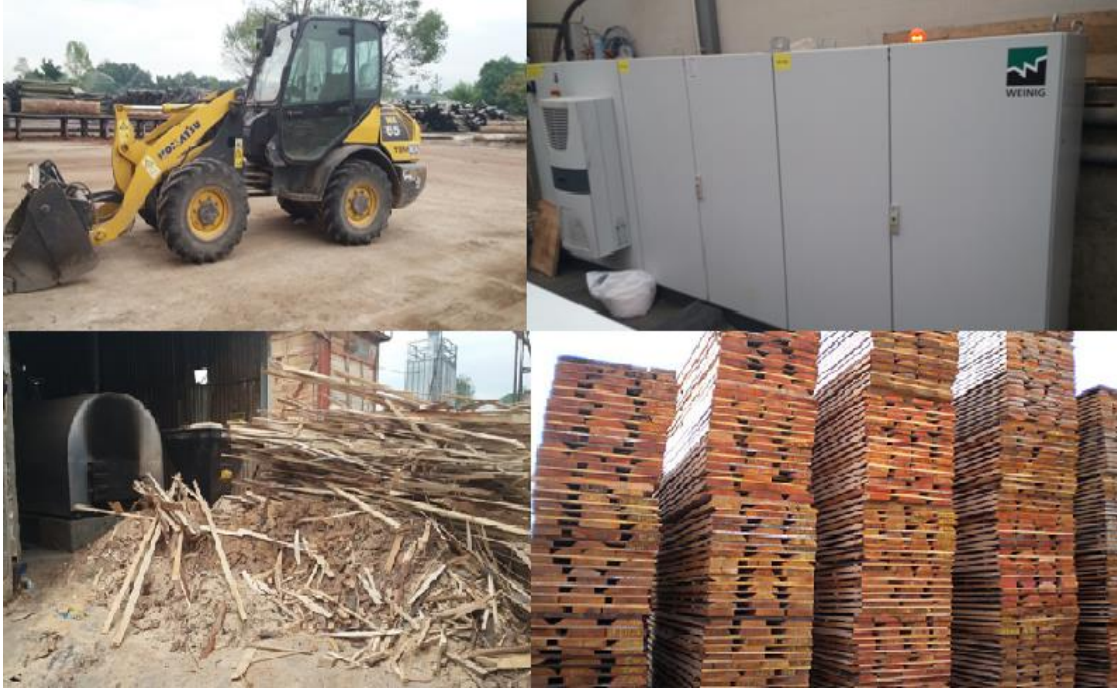
Şekil 15: Uyarı levhalarının bulunmaması ve devrilme ya da yangına sebep olabilecek durumlar.
