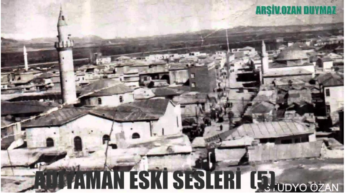
Şekil 15: Adiyaman Eski Görüntüsü Ulu Camii Civarı
