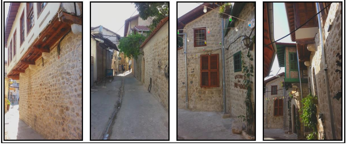
Şekil 61: Gazipaşa Caddesi [D] zonu mevcut durumu.
