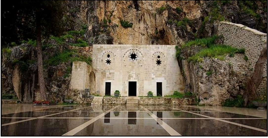
Şekil 20: St. Pierre Kilisesi ( URL-17, 2016).
