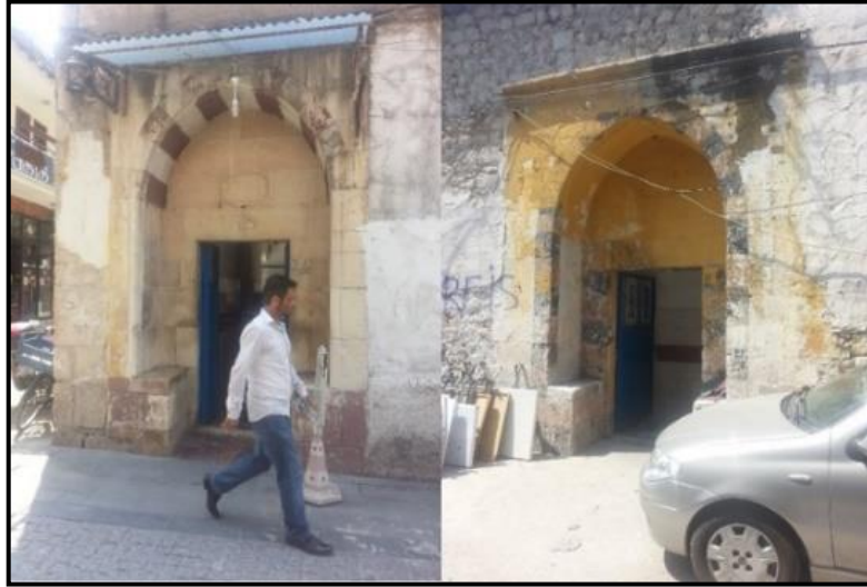
Şekil 19: Cindi Hamamı'nın ön cephe ve yan sokak girişleri.
