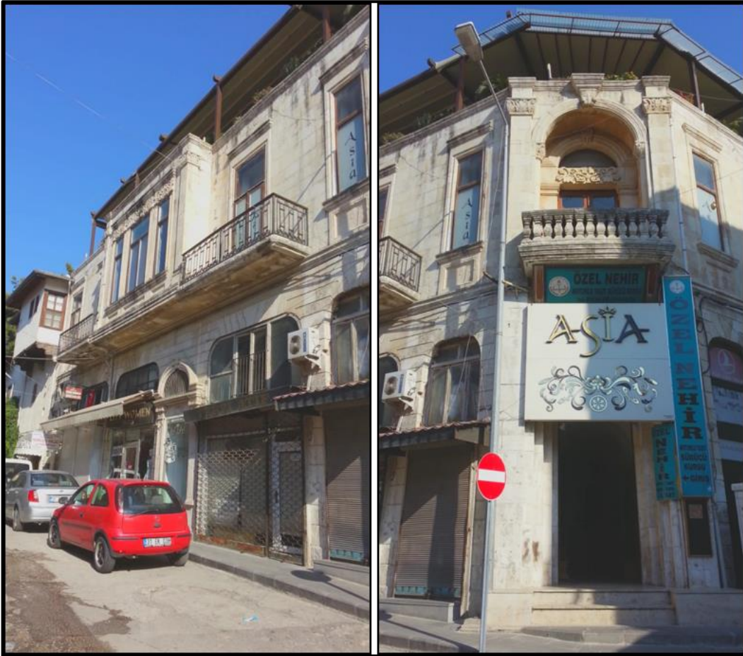
Şekil 90: Gazipaşa Caddesi'nde bulunan tarihi yapı.
