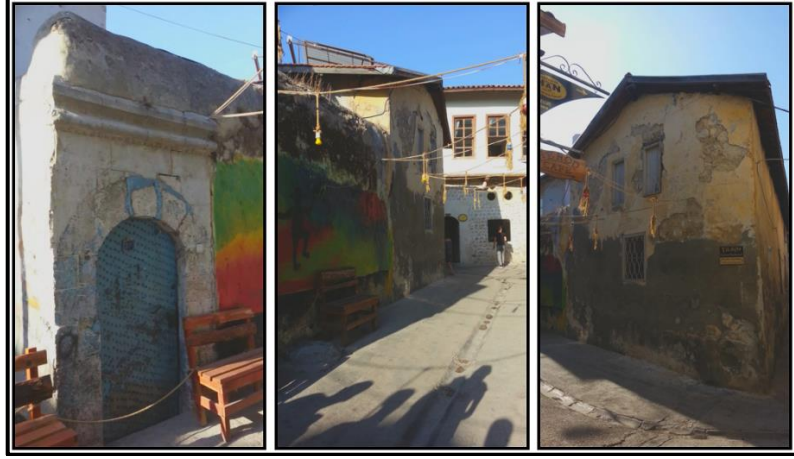
Şekil 63: Gazipaşa Caddesi [E] zonu mevcut durumu.
