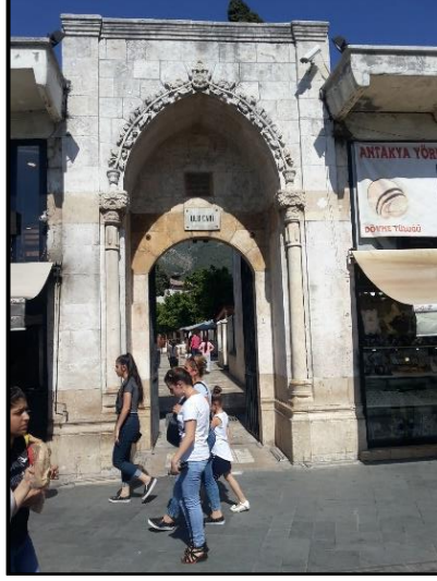
Şekil 18: Ulu Camii'nin ön kapısı.
