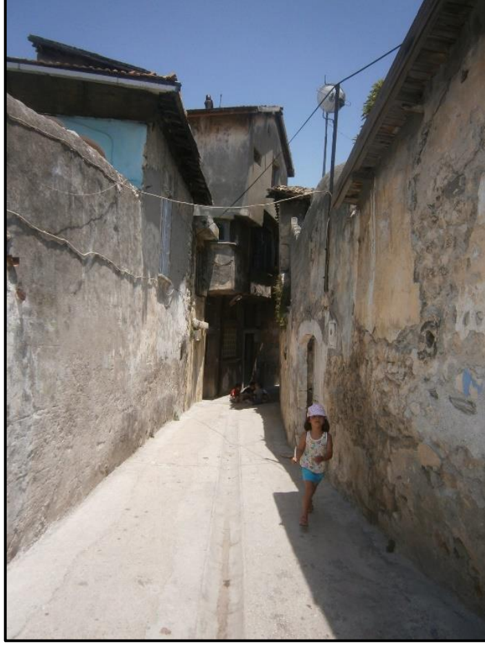
Şekil 36: Oğuzlar Caddesi'nde uygulanmış beton döşeme örneği.
