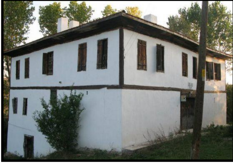
Şekil 3.24: Hasan Bey Konağı dış görünümü (URL-2, 2018).
