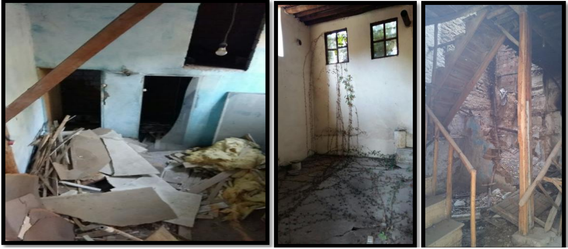
Şekil 5.3: Çalışma Alanındaki Yapılara Ait Görüntüler (Karaarslan, 2019).
