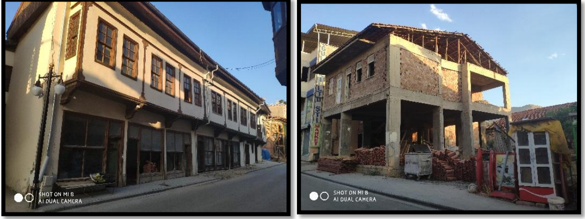
Şekil 5.5: Çalışma Alanındaki Yapılara Ait Görüntüler (Karaarslan, 2019).
