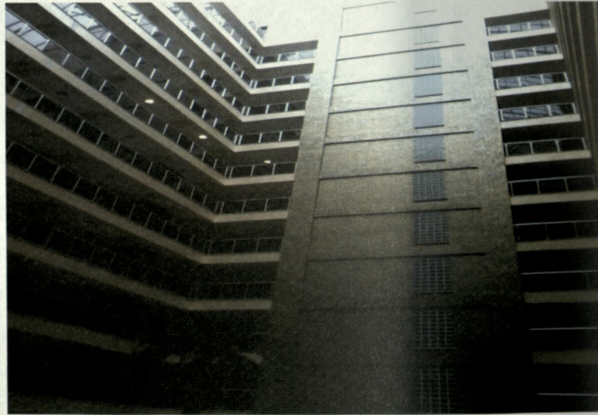
Resim 3.4 Karabük'te Çebioğlu Grup İnşaat Firmasınınca Yapılan Rezidans Binasındaki İç Avlunun Görünümü
