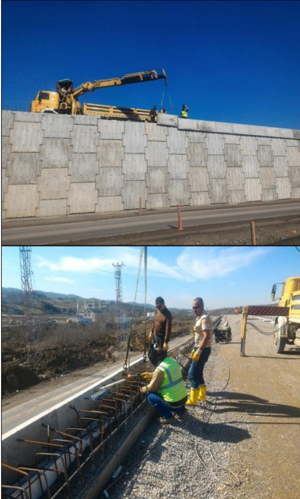
Şekil 26: Harpuşta montajı.
