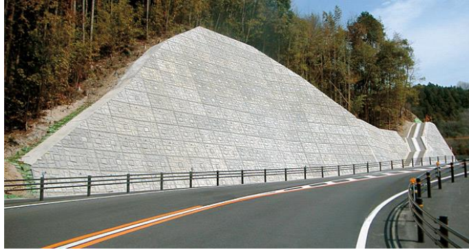
Şekil 9: Eğimli yamaçlarda şevlerin durabilitesini sağlamak için yapılan toprakarme (URL-1, 2016).
