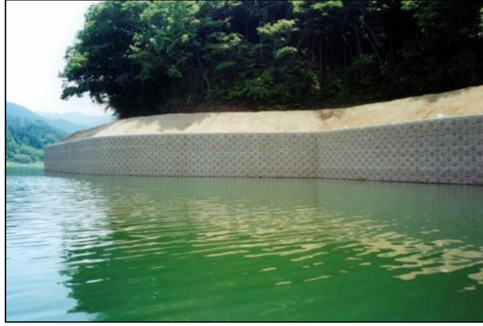
Şekil 6: Su etkisi olan yerlerde yapılan toprakarme (URL-1, 2016).
