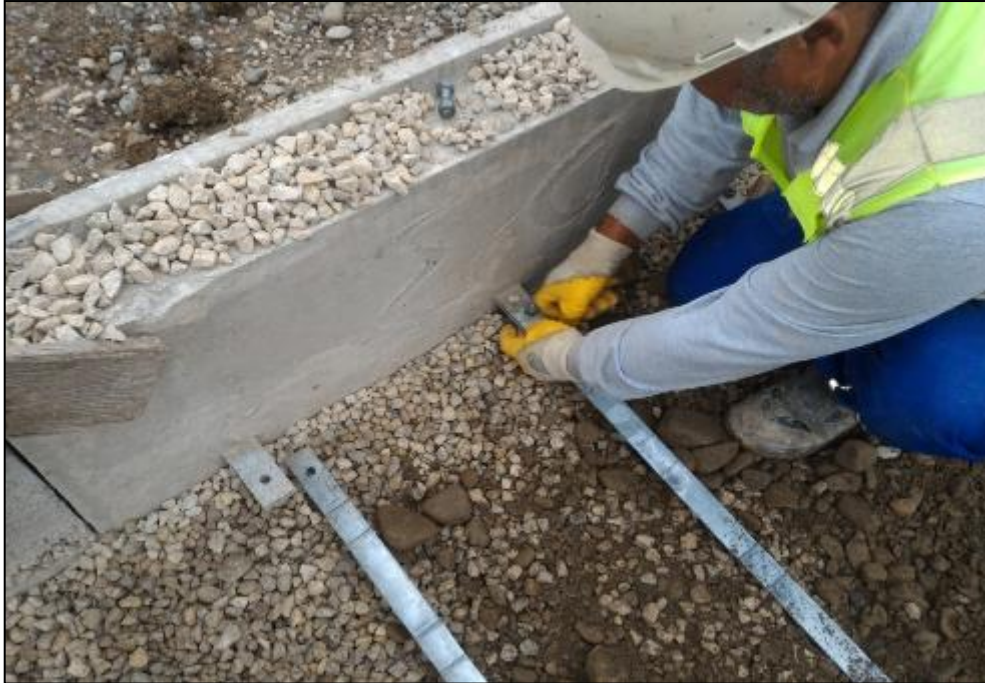
Şekil 16: Pim, cıvata ve somunun uygulanması.
