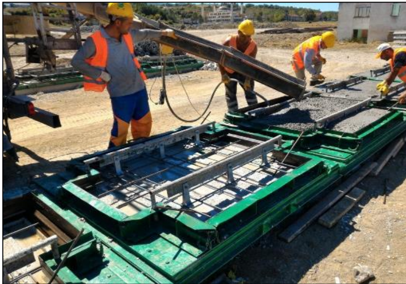
Şekil 12: Prekast panel imalatı.
