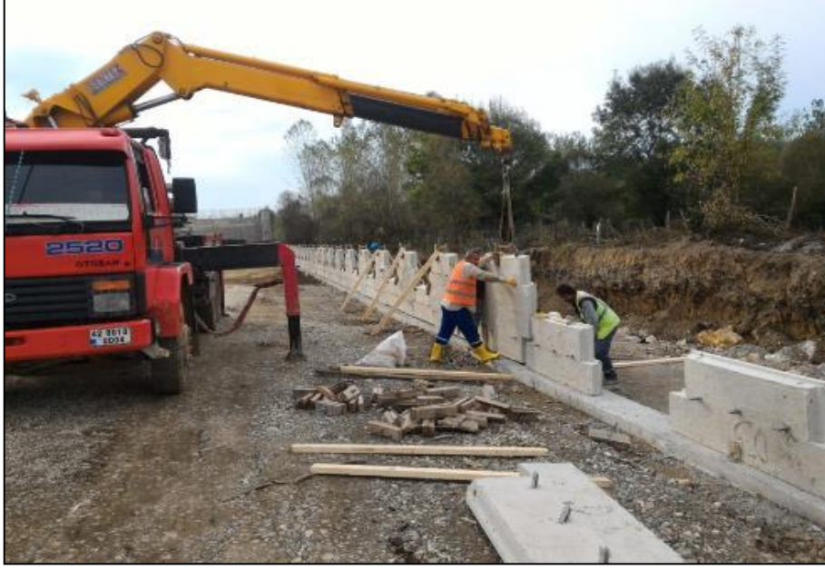
Şekil 20: İlk sıra panellerinin montajı.
