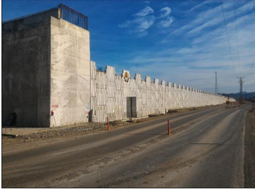
Şekil 10: Şerit donatılı toprakarme duvar yapımı (Kutlubeyyazıcılar – Bartın).
