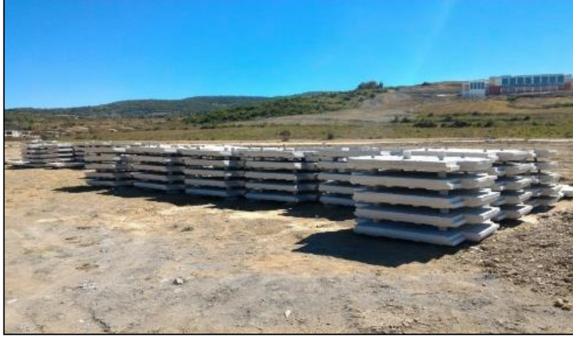
Şekil 13: Prekast panellerin taşınması ve depolanması.
