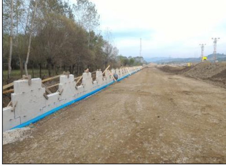
Şekil 24: Drenaj borusu montajı.
