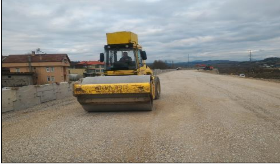
Şekil 25: Dolgu sıkıştırma işlemi.
