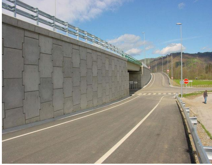
Şekil 8: Köprü ve kavşak yaklaşım rampalarında yapılan toprakarme (URL-1, 2016).
