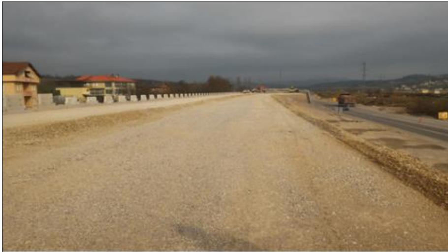
Şekil 11: Şerit donatılı toprakarme duvar yapımında kullanılan dolgu malzemesi örneği.
