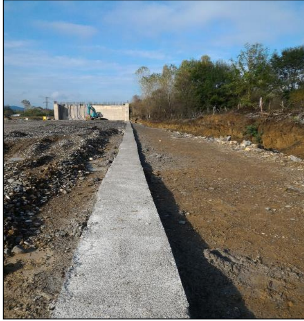
Şekil 19: Tesviye betonunun dökümü.
