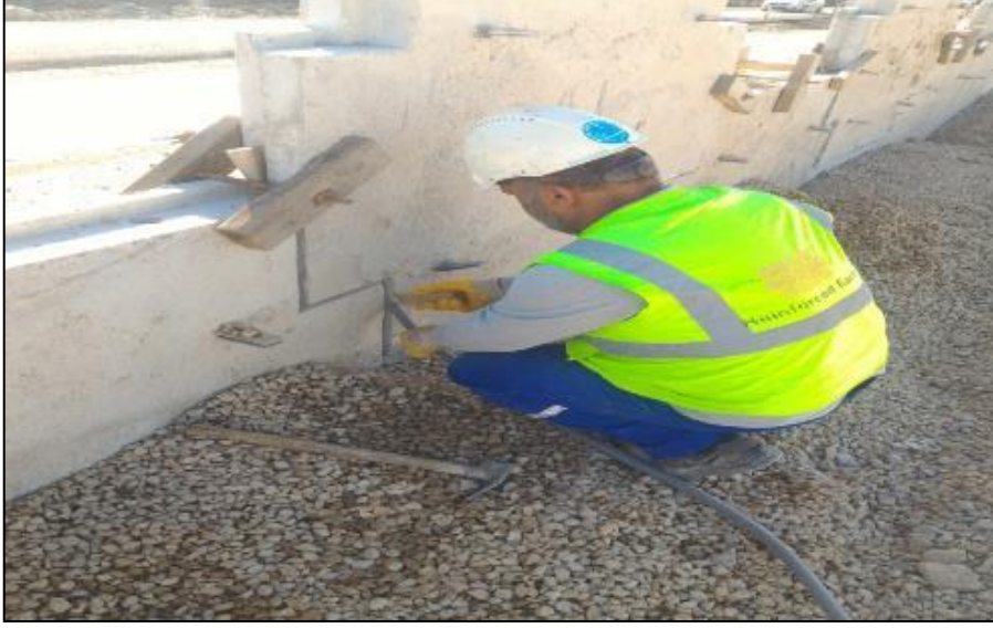
Şekil 17: Polietilen köpük uygulaması.
