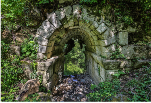
Şekil 25: Amasra Kemerdere Köprüsü
