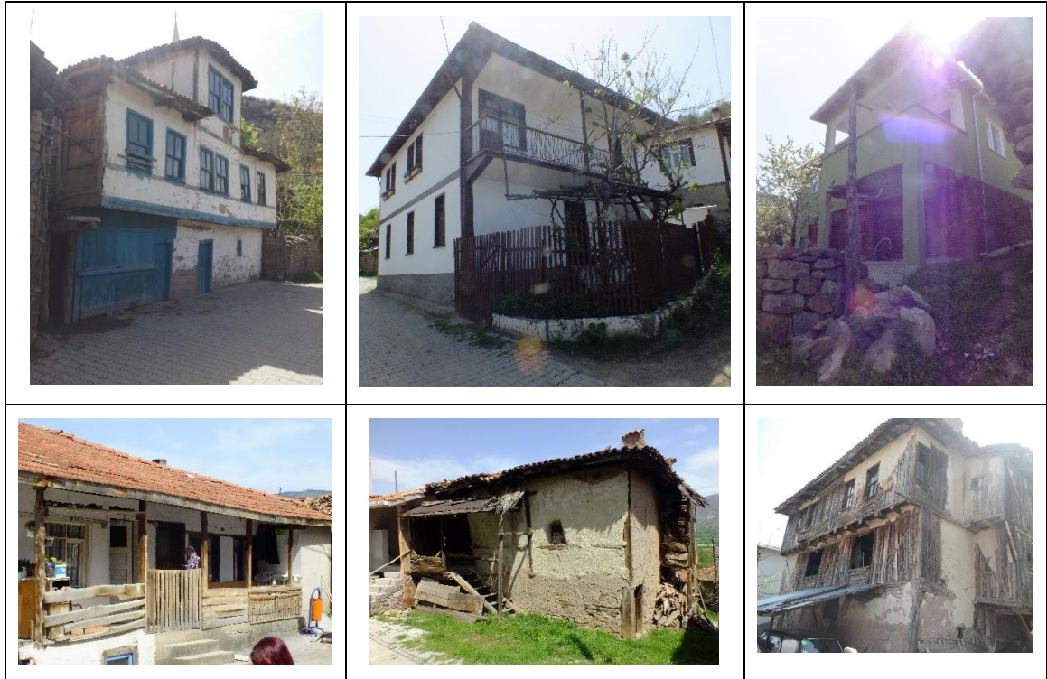
Şekil 4.14: Mahalle konut dokusuna ait görünüm.
