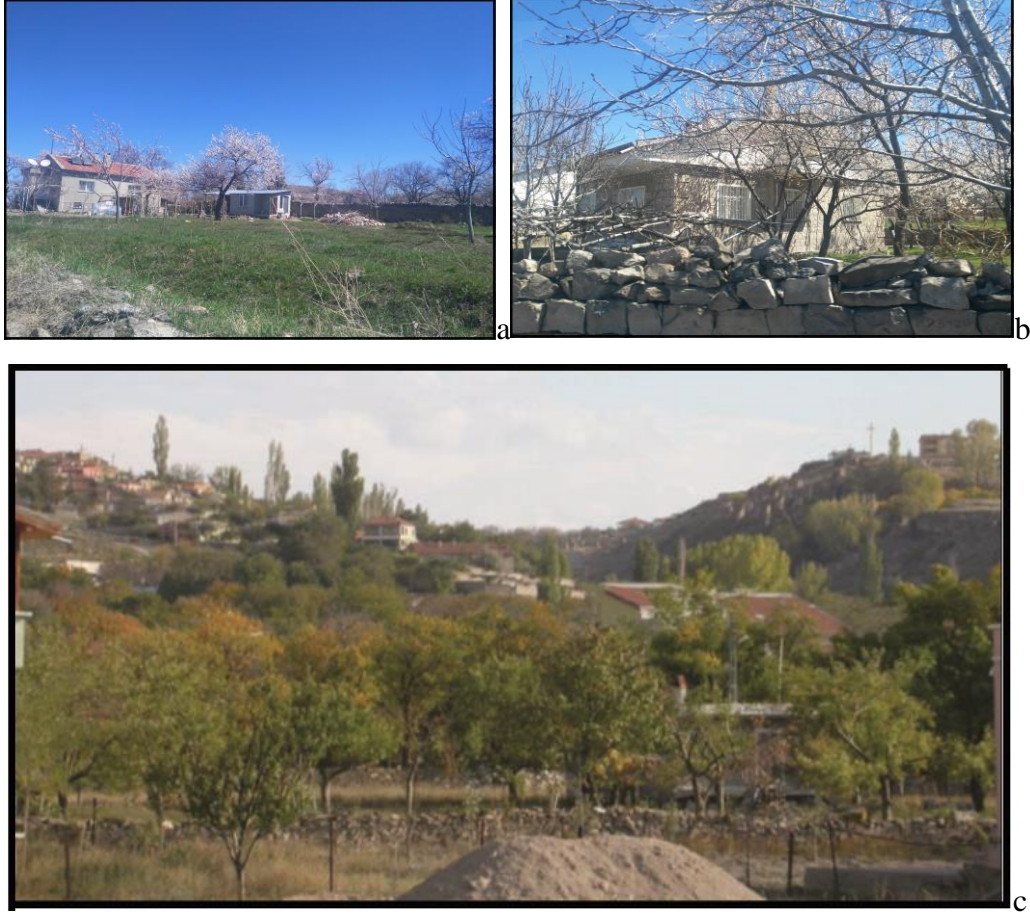
Şekil 29: Bahçeli Mahallesi yerleşim alanı a, b: bağ-bahçe nizamı yapıların görünümü, c: bahçelievlere genel bir bakış (Fotoğraf: Gamze SEÇKİN, 2017).
