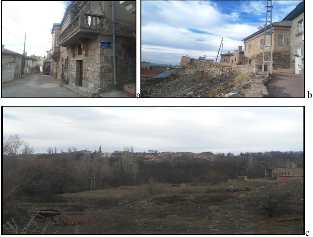
Şekil 33: Güzelköy Mahallesi yerleşim alanı a: sokak yapısı, b: konut görünümü c: genel görünüm (Fotoğraf: Gamze SEÇKİN, 2017).
