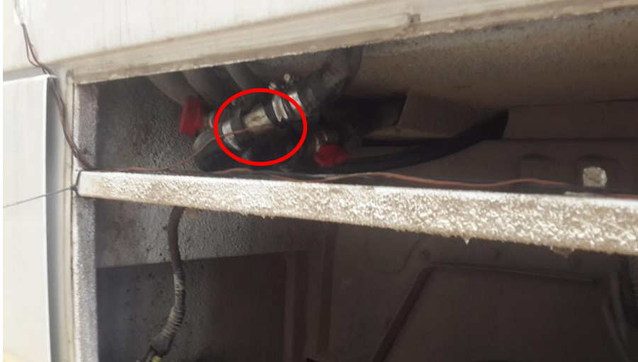
Şekil 4.34: Sıcak su hattı ısıl çift yerleşimi.
