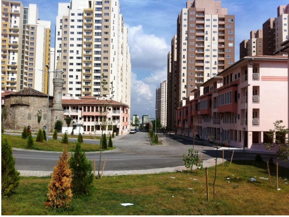
Şekil 2.6: Çalışma alanından bir görünüm (URL-8, 2019).
