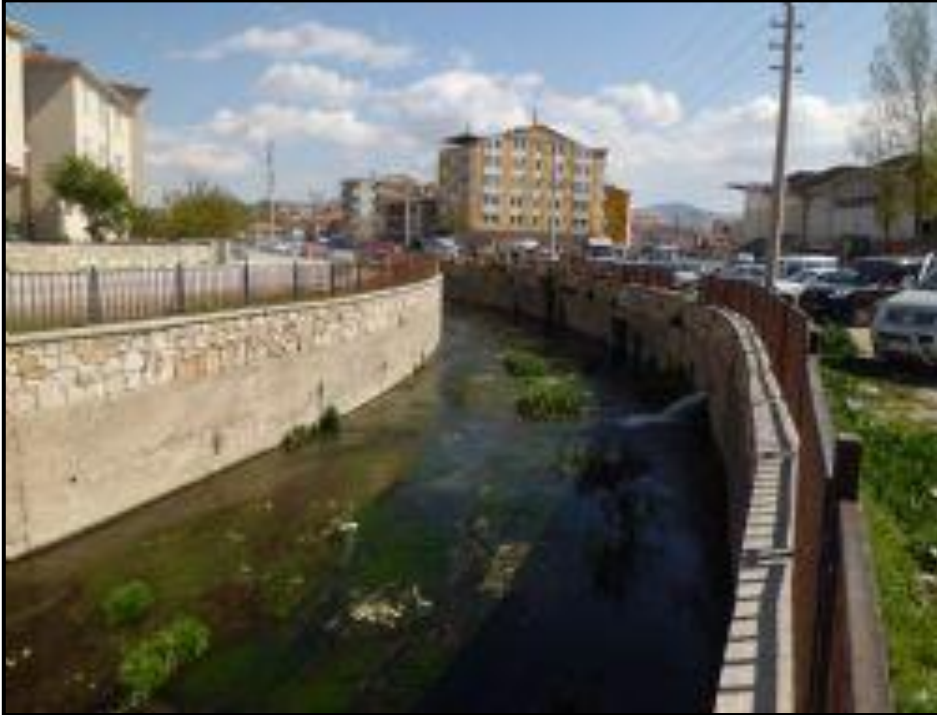
Şekil 4.3: Kılıçözü Çayı'nın ıslah yapılmadan önceki mevcut durumu (URL-24, 2019).
