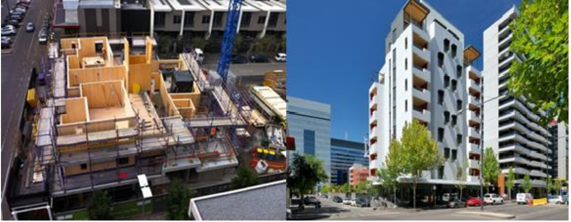
Şekil 1. 18: Forte binası genel görünümü (URL-9, 2012).
