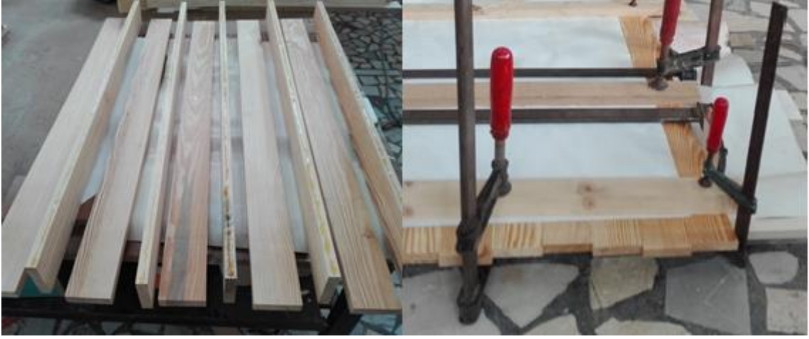
Şekil 3. 5: ÇLK üst- alt tabaklarının tutkallananarak işkence yardımı ile sıkıştırma işlemi (M. GÜLCEMAL, 2018).
