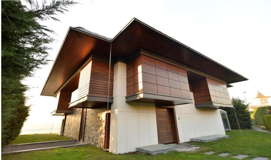
Şekil 1. 5: Ahşap malzemenin panel cephe olarak kullanımı (URL-1,2012).
