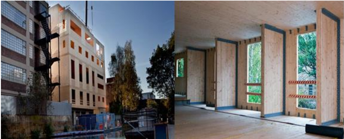
Şekil 1. 17: Whitmore Road konutu yapım aşaması ÇLK kullanımı (URL-8, 2012).
