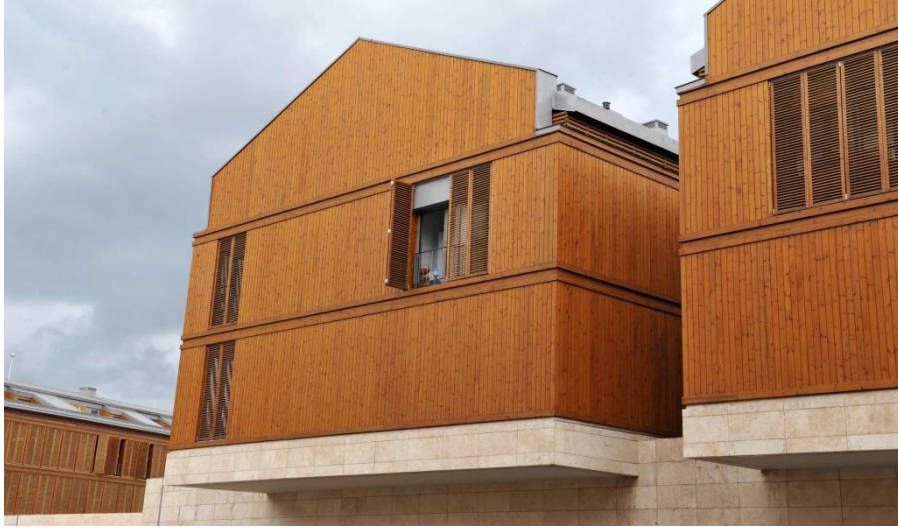
Şekil 1. 4: Ahşap malzemenin panjur ve dış cephe kaplaması olarak kullanımı (URL-1,2012).
