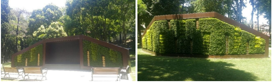
Şekil 3.11: Gülhane Parkı su perdesi dikey bahçe uygulaması.
