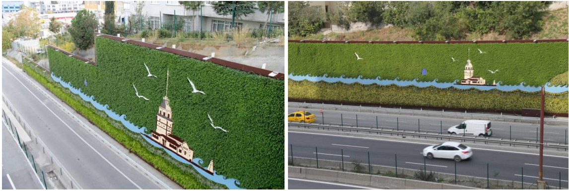
Şekil 3.9: Avrasya Tüneli giriş ve çıkışı yol kenarı dikey bahçe uygulaması (URL-3, 2019).
