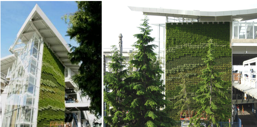
Şekil 2.13: Vancouver Uluslararası Havalimanı dikey bahçe uygulaması, Kanada ( URL-5, 2018).
