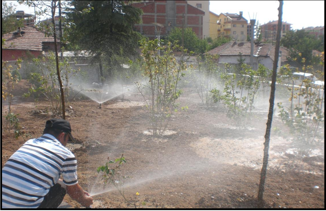
Şekil 3.7 Gündoğan Parkı sprink ayarları yapılırken (Fotoğraf: Cem Küçüksayan 2008).
