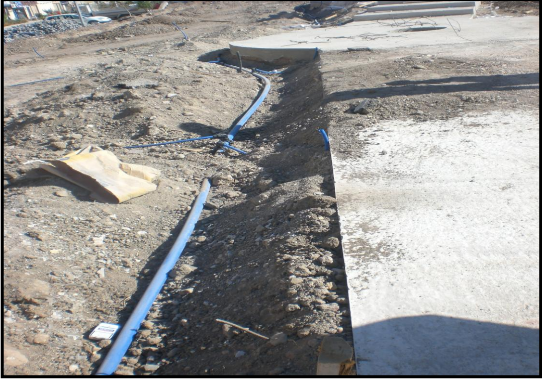
Şekil 3.12 Otomatik sulama sistemi uygulama aşaması (Fotoğraf: Cem Küçüksayan 2008).
