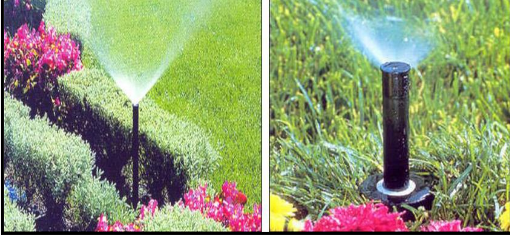
Şekil 2.13 Püskürtücü (Sprey) Pop-up Başlıklar (URL-4 2009).
